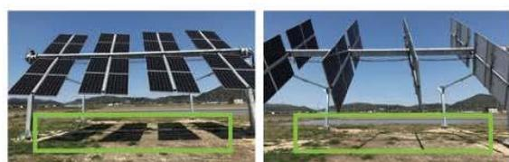
加えて、太陽光を3次元で追尾するプログラムによって、高い発電効率を実現し、強風や積雪等の災害時には自動的に太陽光パネルのポジションを変更させることで、破損等による被害を防ぐことができます。
